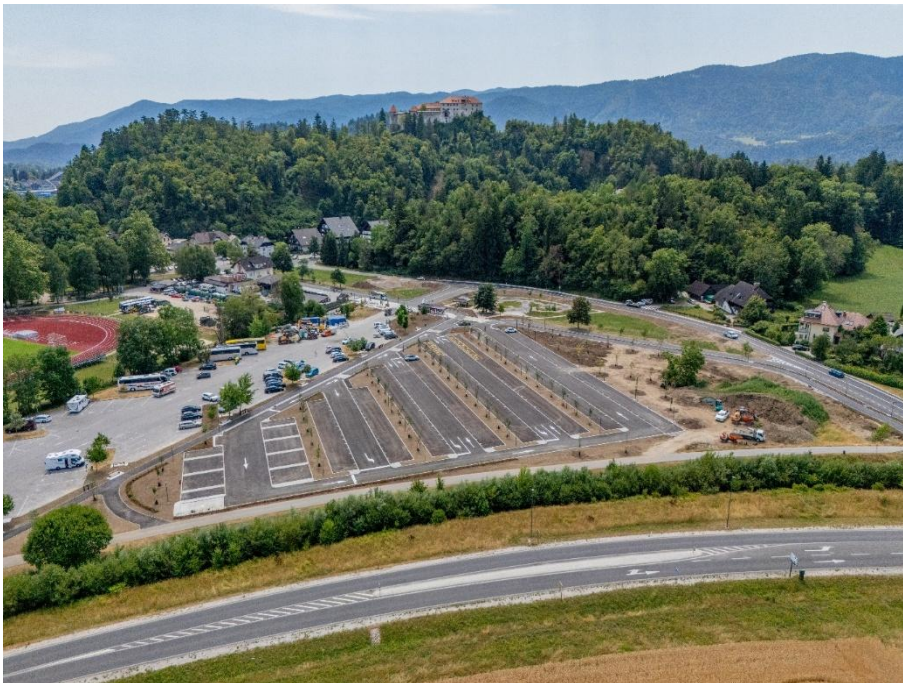
P+R Centralnega parkirišča. Foto: arhiv Občine Bled
