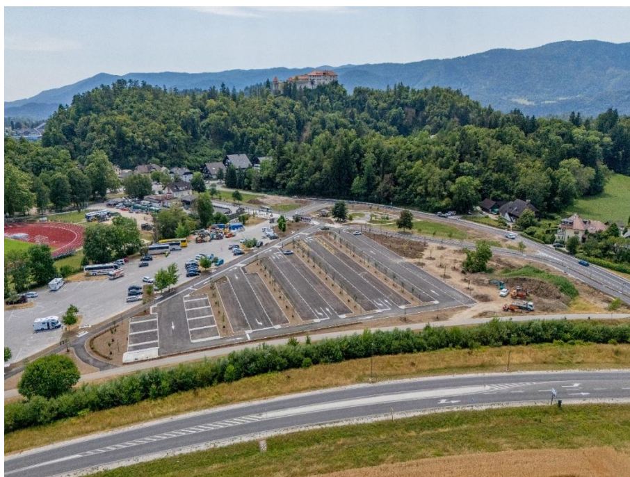
P+R Centralnega parkirišča. Foto: arhiv Občine Bled
