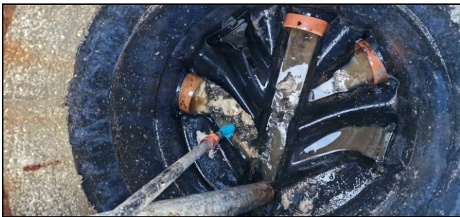
30.1.2025: Zamašitev kanala na Partizanski cesti, ostanki asfalta v jaških
