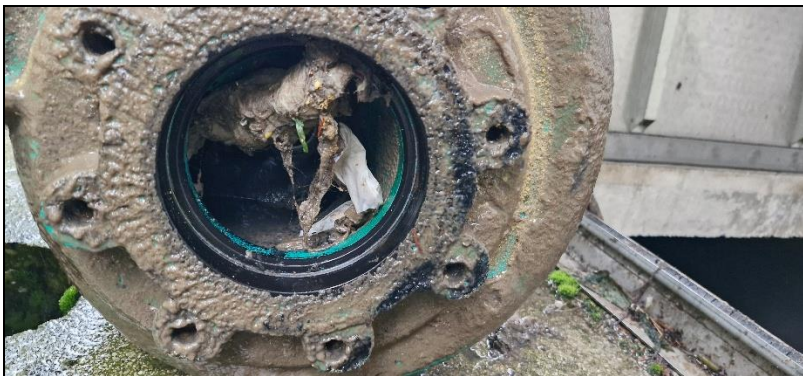
22.8.2025: Vhodno črpališče na ČN, dvig dveh črpalk in čiščenje
