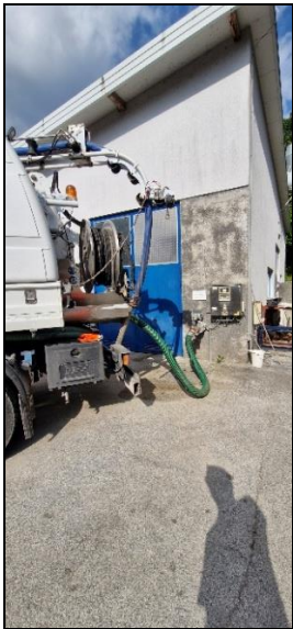
22.8.2025: Vhodno črpališče na ČN, dvig dveh črpalk in čiščenje
