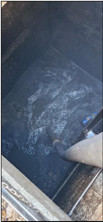
30.1.2025: Zamašitev kanala na Partizanski cesti, ostanki asfalta v jaških
