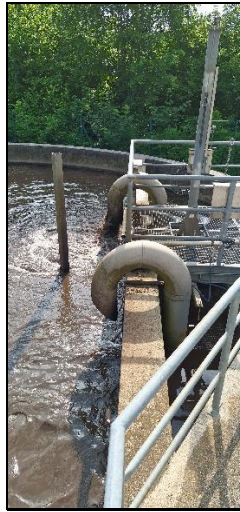
18.8.2025: Zamašen odtok centrifuge, čiščenje celotne odtočne cevi s kanal-jetom
