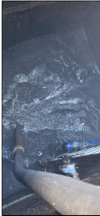
30.1.2025: Zamašitev kanala na Partizanski cesti, ostanki asfalta v jaških
