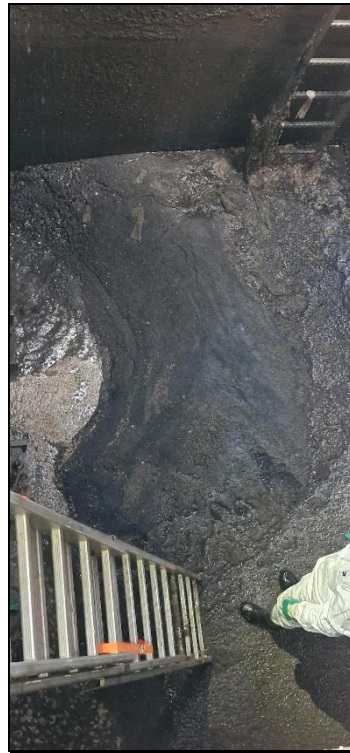
30.1.2025: Zamašitev kanala na Partizanski cesti, ostanki asfalta v jaških
