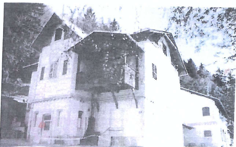
Fotografija gospodarskega objekta pred rušitvijo, kjer že manjka lesen balkon na zahodni fasadi bivalnega dela – vile za osebje (vir: ZVKDS OE Kranj, dr. Nika Leben).
