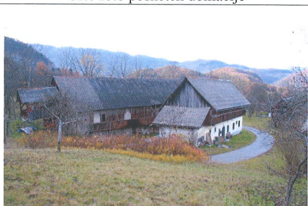
Kupljenik 12 – stanovanjski in gospodarski objekt sta postavljena vzporedno s plastnicami
