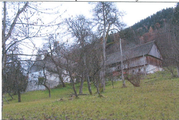
Kupljenik 11 – gospodarsko poslopje je postavljeno vzporedno s plastnicami, stanovanjski objekt je postavljen pravokotno na plastnice
