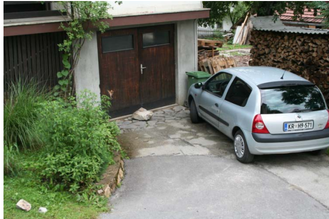
Slika 16: Poškodovana garažna vrata in vozilo
