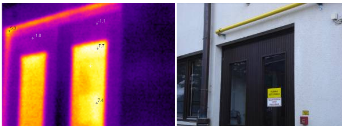
Slika 14: Vrata v kotlovnico vrtca Bled
