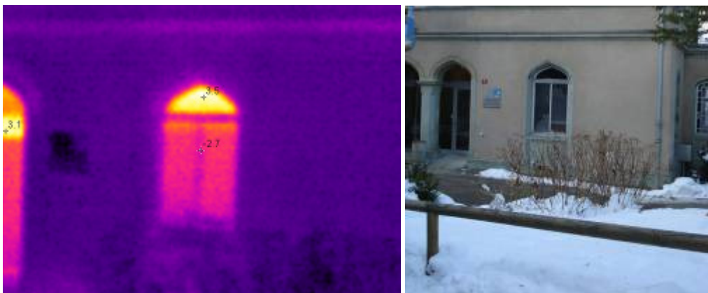
Slika 6: Okno z enojnim steklom na občinski stavbi
