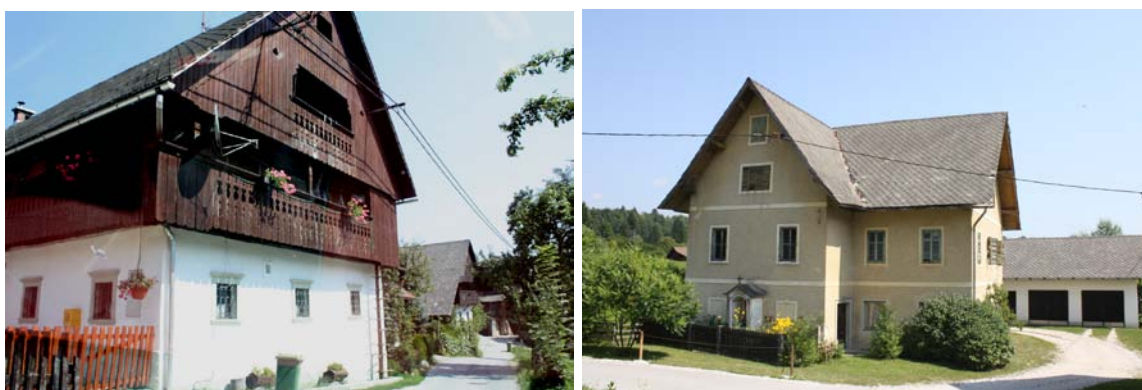
Slika 6: Tipologija objektov vaškega jedra (Bodešče, Ribno).
