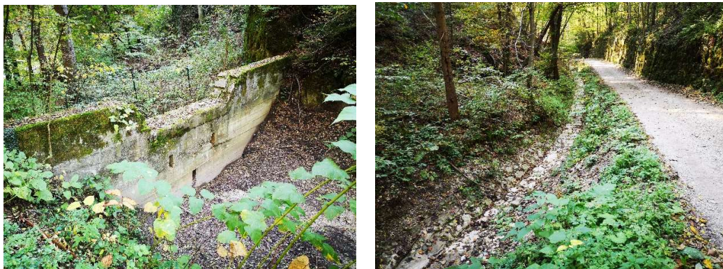
Slika 7,8: reguliran del Solznika z zaplavno pregrado nad kampom Zaka
