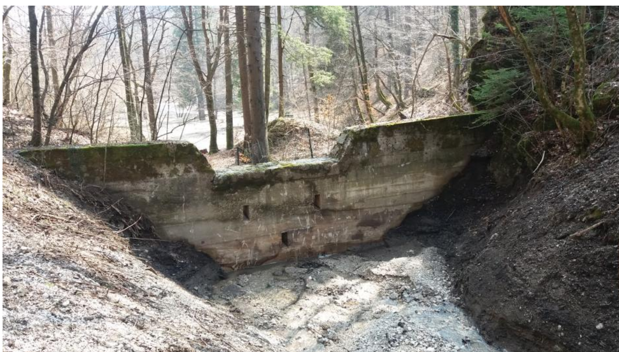
Slika 2: Pregrada na potoku nad kampom
