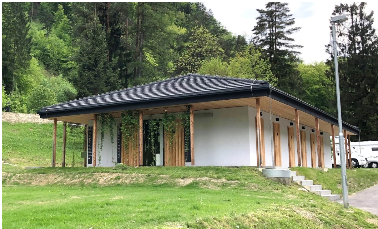
Fotografije servisne in sanitarne stavbe 4 – severna, glavna vstopna fasada
