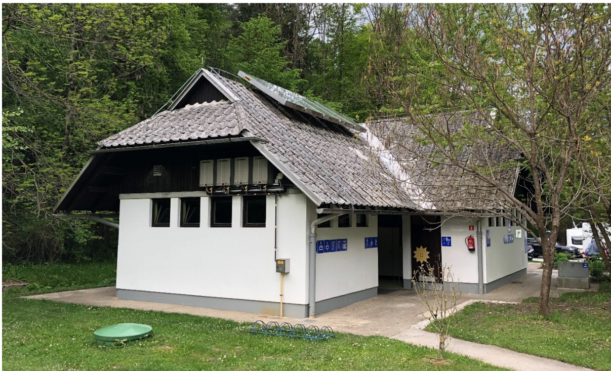
Fotografije servisne in sanitarne stavbe 2 – vstopna stran
