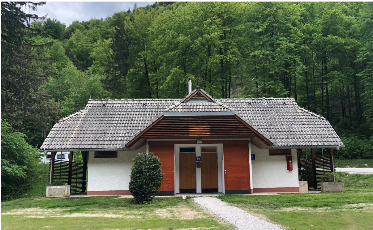
Fotografije servisne in sanitarne stavbe 3 – južna, glavna vstopna fasada
