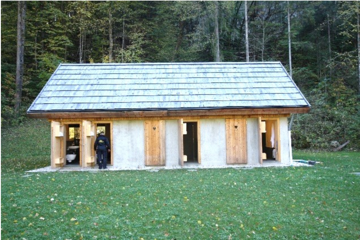
Fotografije servisne in sanitarne stavbe 5 – severna, glavna vstopna fasada
